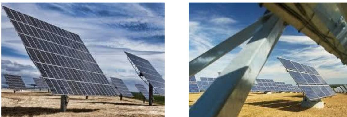
Figure 7 : Type d'installation mobile sur 1 axe (à gauche) et sur 2 axes (à droite)
