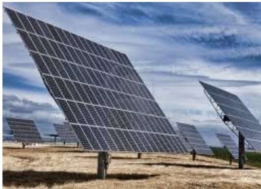
Figure 7 : Type d'installation mobile sur 1 axe (à gauche) et sur 2 axes (à droite)
