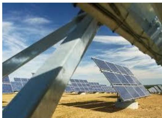
Figure 6 : Type d'installation mobile sur 1 axe (à gauche) et sur 2 axes (à droite)
