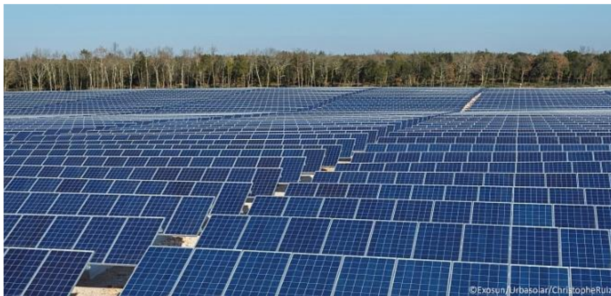
Figure 5 : Centrale PV typique (structures fixes sur un niveau)
