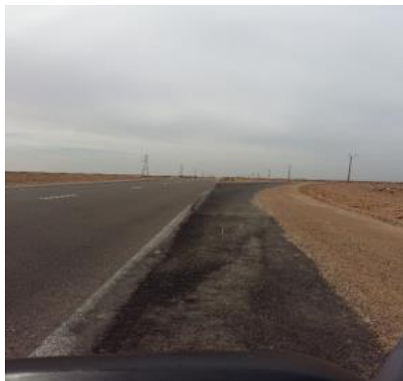
Photo 7 : Route d'accès au site (3km) nouvellement construite
