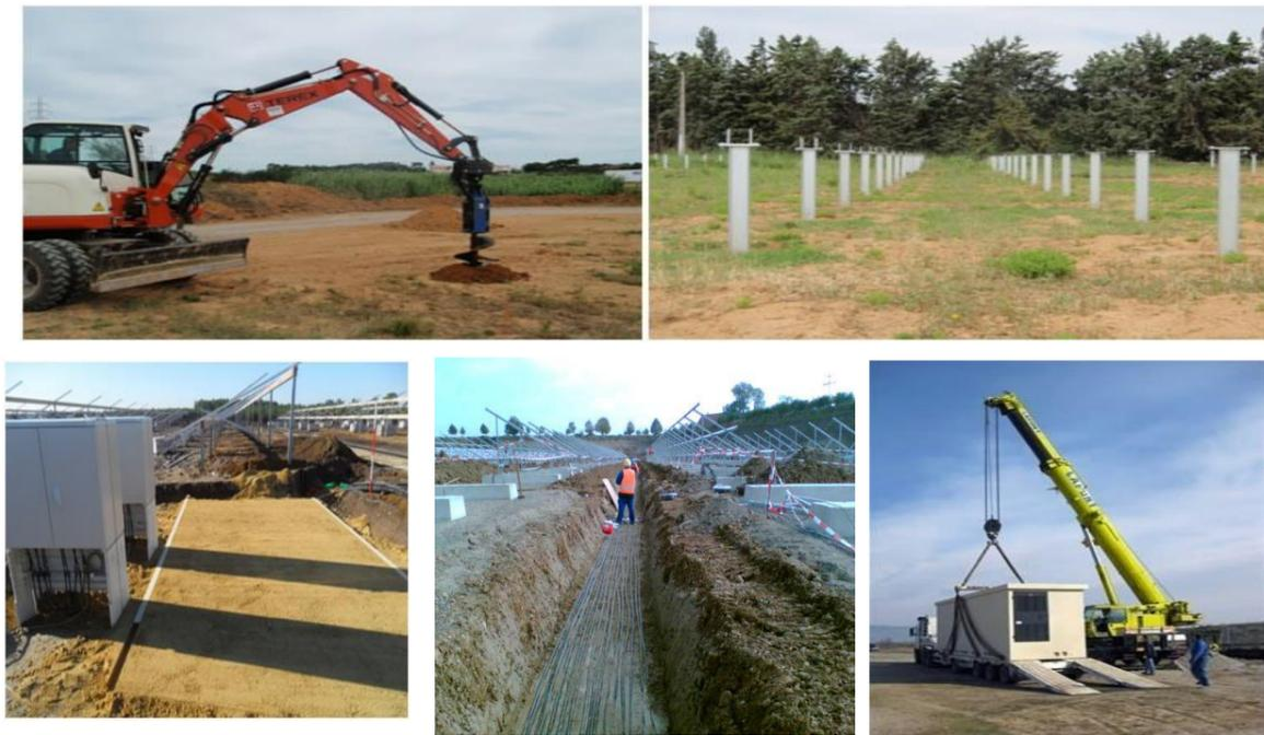
Figure 65 : Etapes types de construction du complexe solaire
