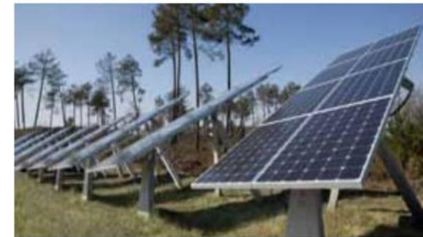
Figure 15 : Suiveurs à rotation mono-axiale
