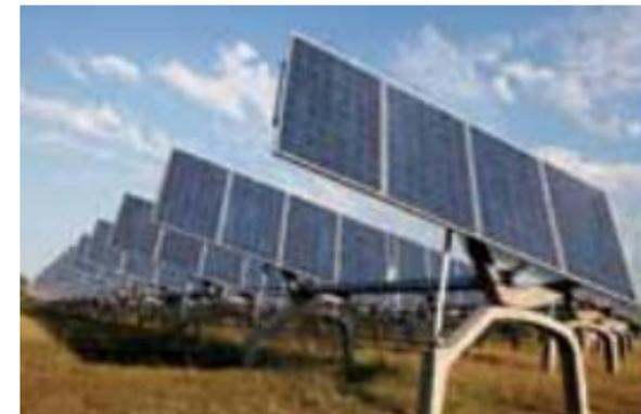
Figure 16 : Suiveurs à rotation bi-axiale
