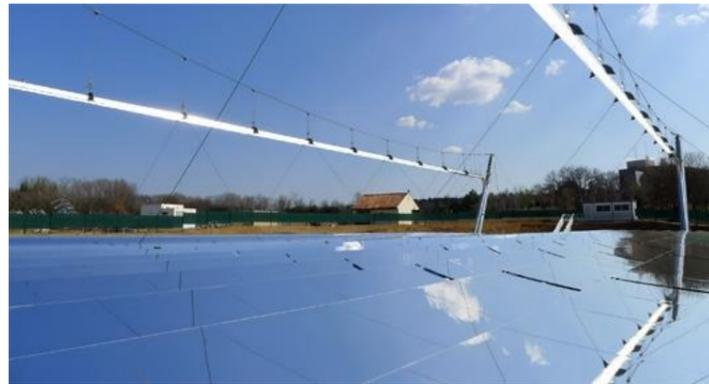
Figure 27 : Centrale solaire à capteurs linéaires de Fresnel et caloporteur eau/vapeur
