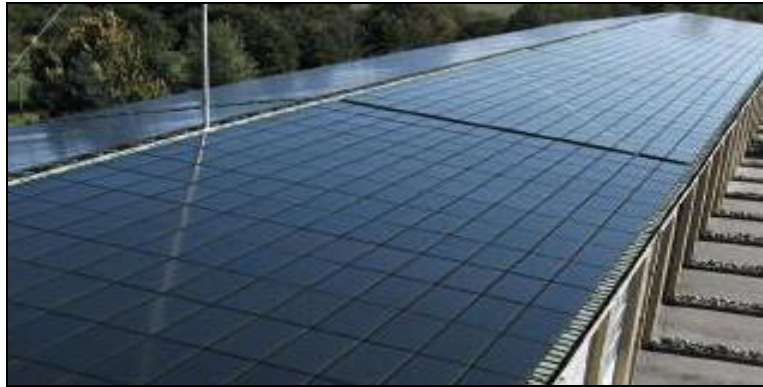
Figure 31 : Module utilisant des cellules de type CIS
