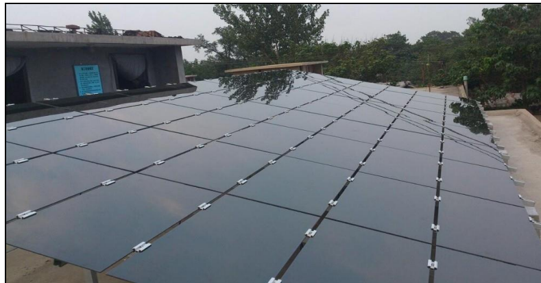
Figure 32 : Module utilisant des cellules de CdTe
