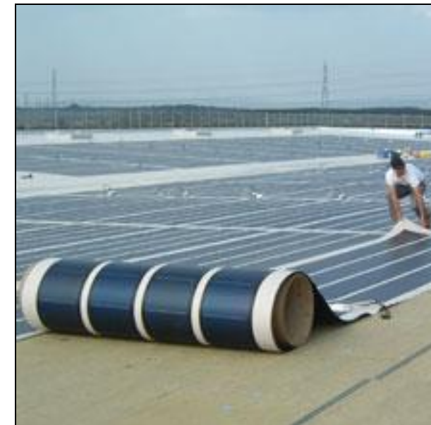
Figure 30 : Module utilisant des cellules silicium amorphe
