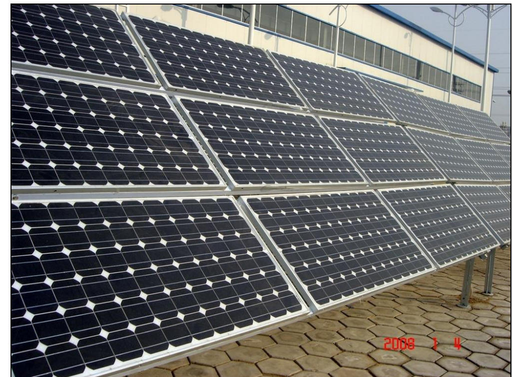
Figure 27 : Module utilisant des cellules monocristallines
