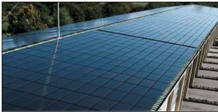
Figure 31 : Module utilisant des cellules de type CIS
