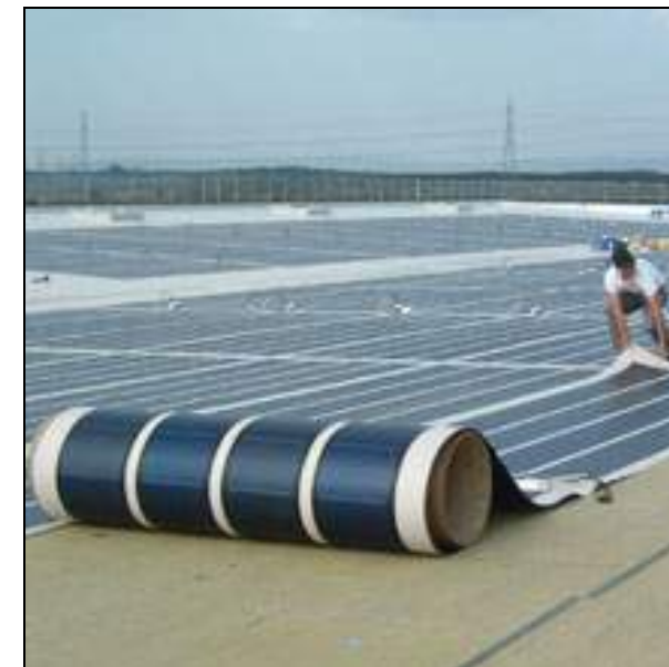
Figure 30 : Module utilisant des cellules silicium amorphe
