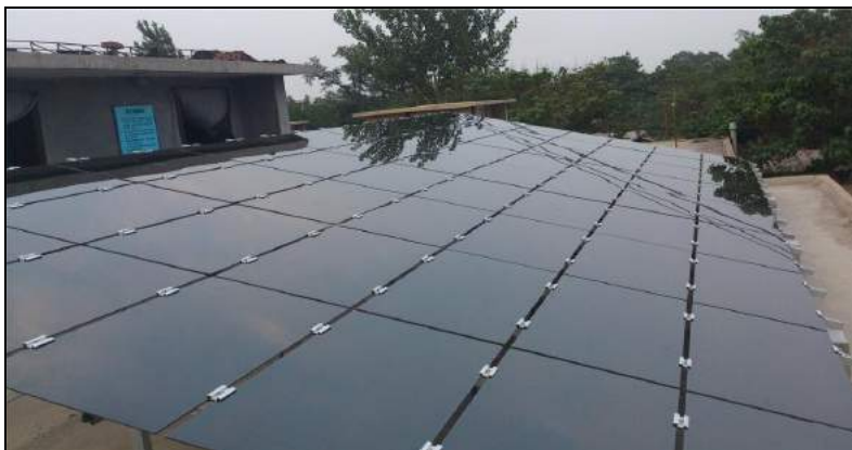
Figure 32 : Module utilisant des cellules de CdTe
