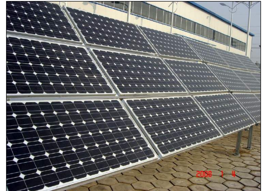
Figure 27 : Module utilisant des cellules monocristallines
