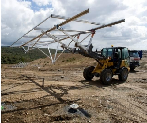
Figure 8: Exemple de montage des structures
