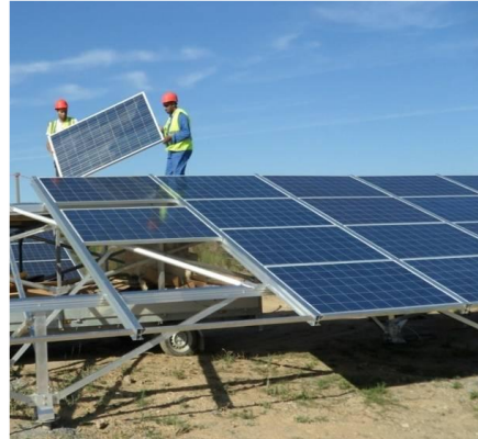
Figure 9: mise en place des panneaux sur les structures
