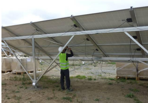
Figure 10: Câblage des panneaux
