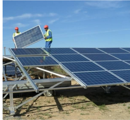
Figure 12: mise en place des panneaux sur les structures
