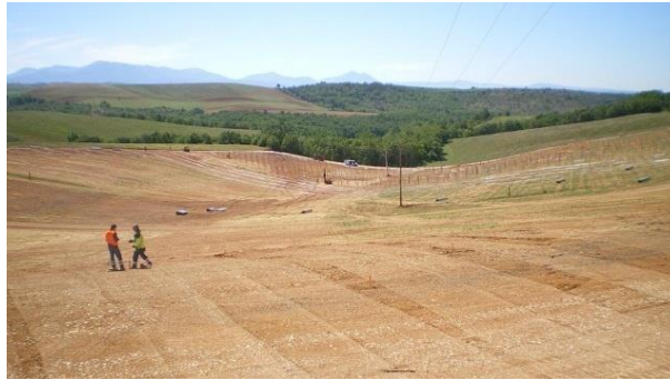
Figure 10: Exemple de l'étape de piquetage
