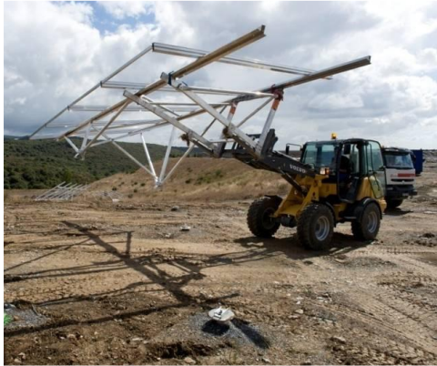
Figure 11: Exemple de montage des structures
