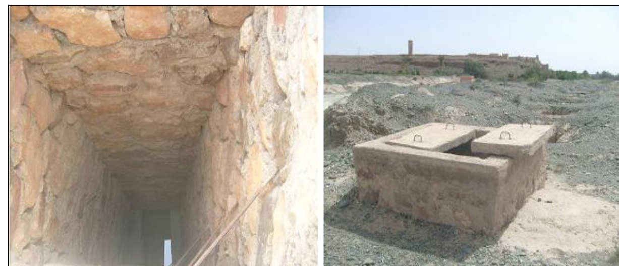
Photo 7 : Khettaras réhabilitée au niveau de Tiflité
