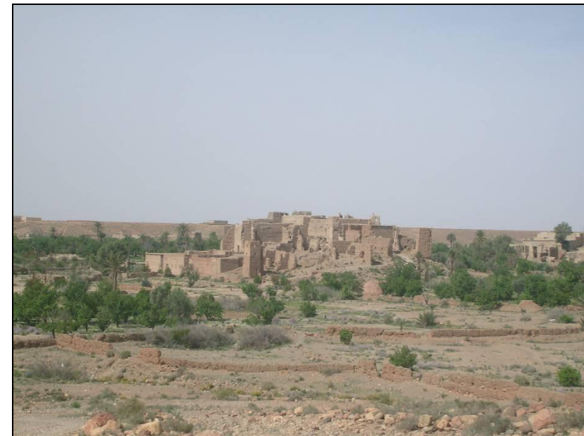
Photo 33 : L'ancien rassemblement d'habitats abandonnés au douar de Tiflité
