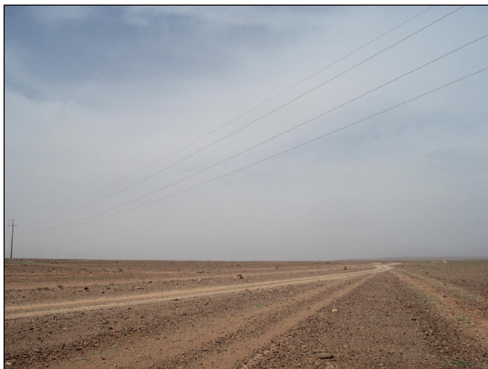
Photo 17 : Ligne électrique de 60 kV traversant le site du complexe solaire d'Ouarzazate avant son démantèlement en 2013
