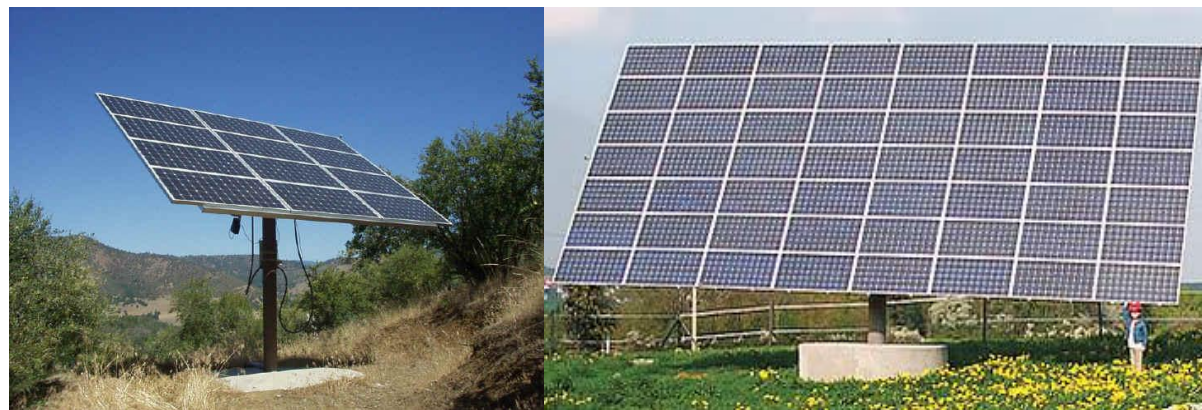
Figure 27 : Tracker 1 axe (à gauche) et 2 axes (à droite)
