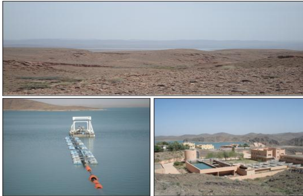
Photos 5 : En Haut : Retenue du barrage Mansour Ed Dahbi observée à partir de la bordure Sud Ouest du site du complexe solaire d'Ouarzazate
